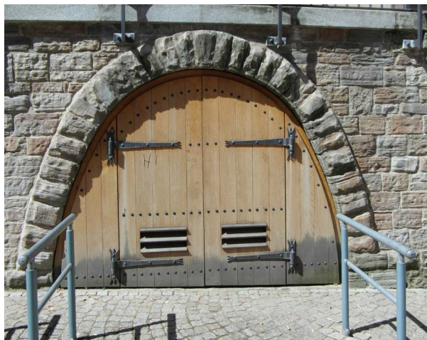
Eingang zum Ratskeller in Sangerhausen, Foto: LHB
