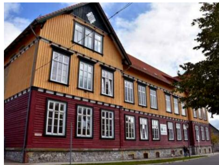
Die Grundschule „Dr. Hermann Blumenau“ in Hasselfelde soll einen neuen Anbau für die Sanitäranlagen erhalten. Der Startschuss für die Bauarbeiten soll noch 2020 fallen
